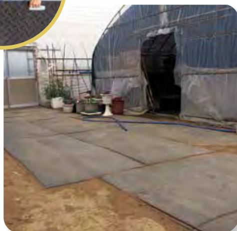
ビニールハウスアプローチ養生
